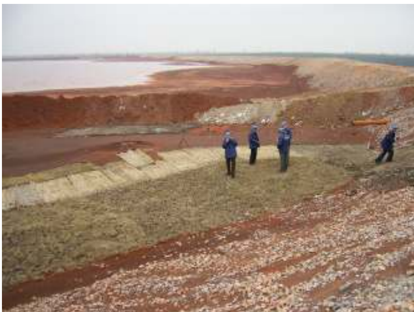
Рис 2. Размещение дернины и тростниковых матов для пылеподавления на поверхности первого шламохранилища НГЗ
