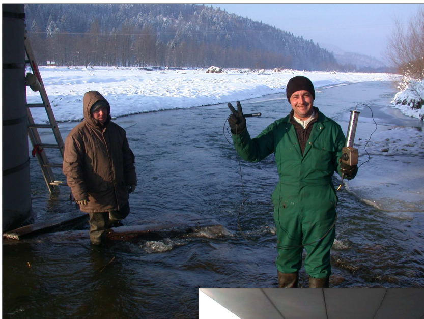
Установка польового модема на мостовій опорі на р. Сірет (Замовник: Дністровсько- Прутське БУВР Держводгоспу) )
